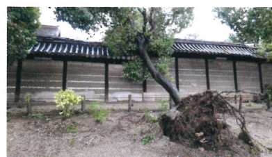
築地塀工事範囲 全長：63.3m、軒幅：2.2m
